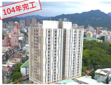
104年完工 文山區興隆1 區公共住宅 完工日期: 104/5/15 戶數: 272戶 總經費: 10.86億
