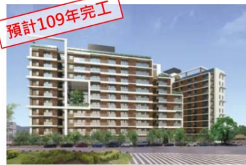
預計109年完工 北投區新奇 岩公共住宅 開工日期: 106/5/26 戶數: 288戶 總經費: 12.4億
