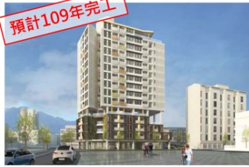
預計109年完工 南港區中南 公共住宅 開工日期: 106/11/9 戶數: 119戶 總經費: 6.63億
