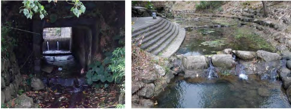
圖 6.3-5 小坑溪現有箱涵、防砂壩與固床工
