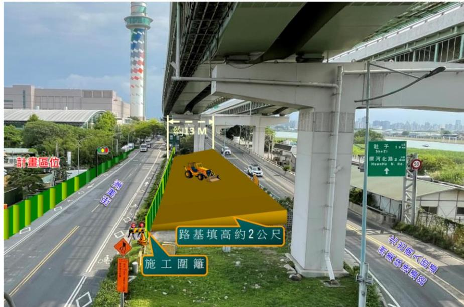
圖 2.8-3 第二階段施作排水箱涵與匝道施工便道示意圖
