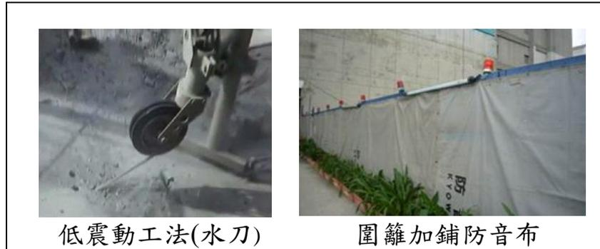
圖2.4.2-1 新建結構與既有設施銜接施工
