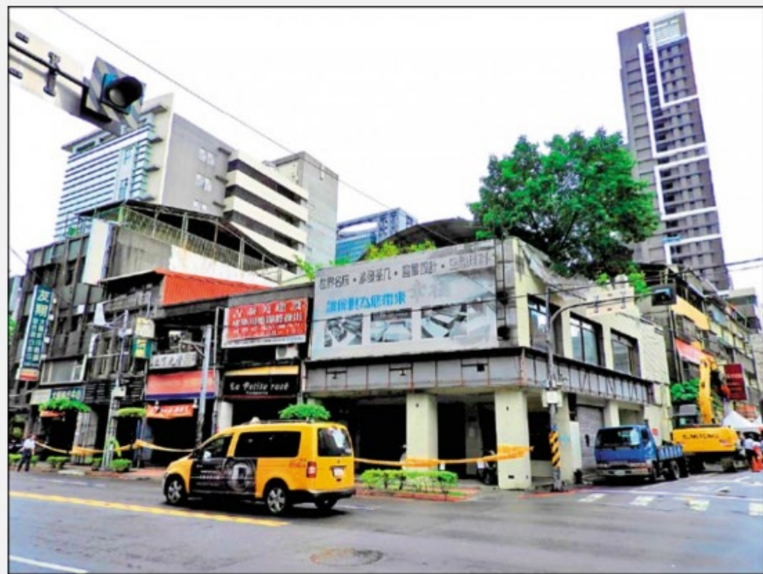
內政部部務會議昨通過修正草案，針對小基地的危老案，擬給予2%容積獎勵，預計公布後兩週實施。圖為申請危老重建計畫的板橋老舊公寓。（資料照）
