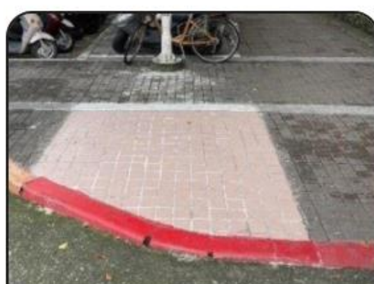
臺大醫院-斜坡道順平
