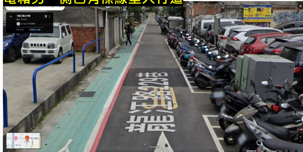
電箱另一側已有標線型人行道
