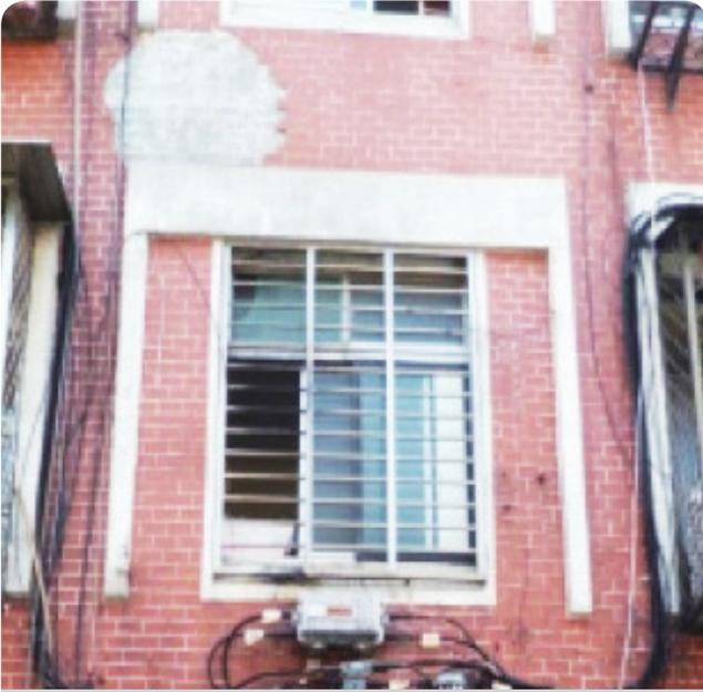
建築物外牆飾面剝落狀況
