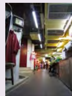
空調及照明設備更新
