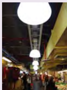
空調及照明設備更新
