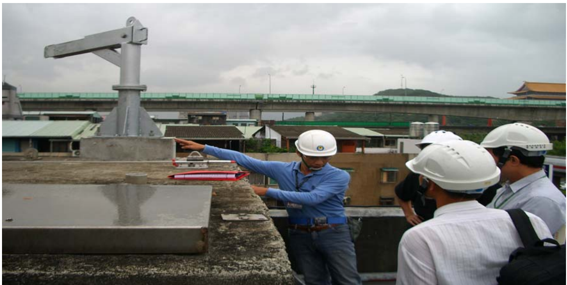
大樓外牆清潔作業安全宣導示範設備
