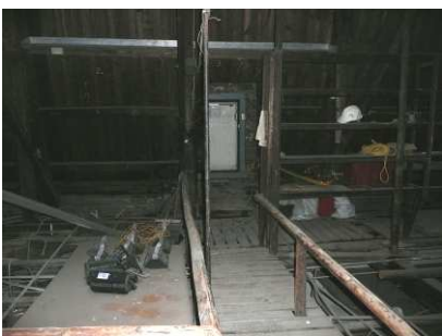
說明：3 樓閣樓貓道。
