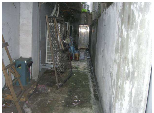
說明：罹災者及花格鋁窗墜落於 1 樓防火巷地面。
