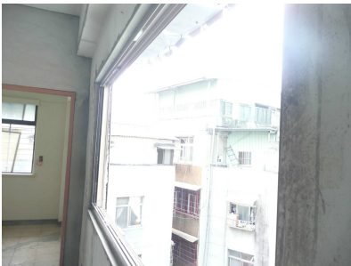
說明：欲拔除上方雨庇釘子。
