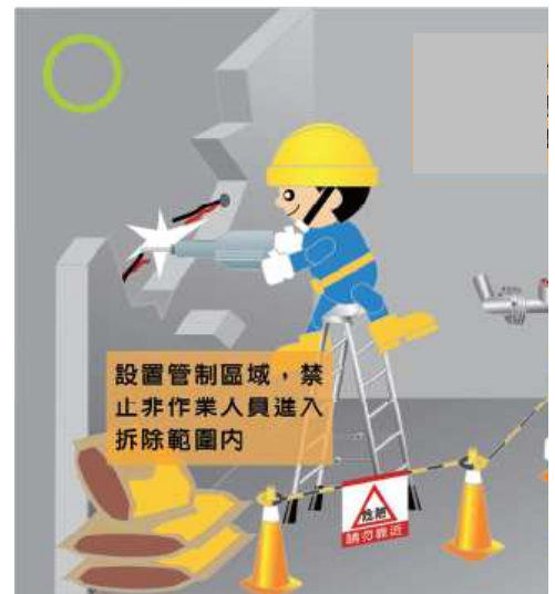
說明：具有危險之拆除作業區，應設置圍柵或標示，禁止非作業人員進入拆除範圍內，並選任專人於現場指揮監督。
