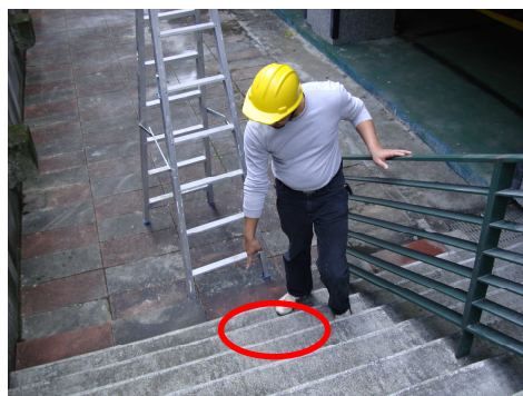
說明：勞工跌坐於第 2、3 階之水泥階梯上。
