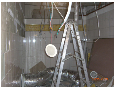
說明：欲拆除之空調設備。
