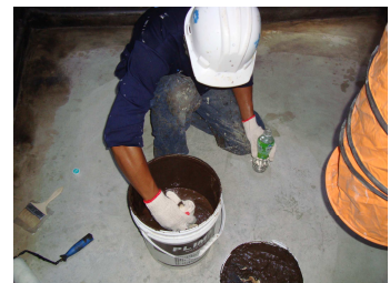
說明：改善情形（採用通風設備及改用瀝青防水材料）。
