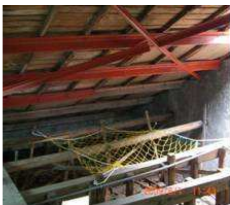
說明：屋架塗紅丹漆防鏽作業。
