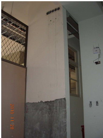
說明：教室牆壁現場。
