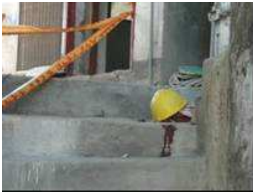
說明：職災發生現場。
