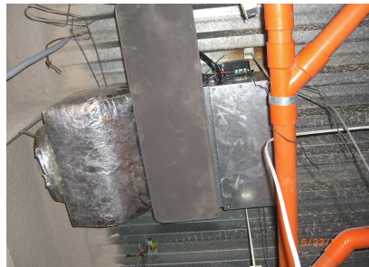
說明：大樓女廁拆除現場。
