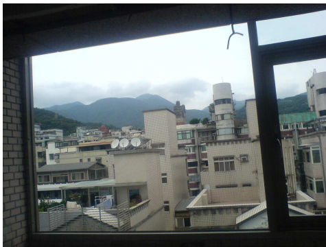
說明：現場原欲安裝玻璃之窗戶（1.8m*2.0m）。
