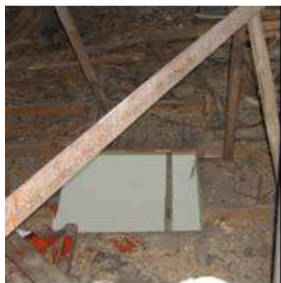
說明：天花板維修孔。
