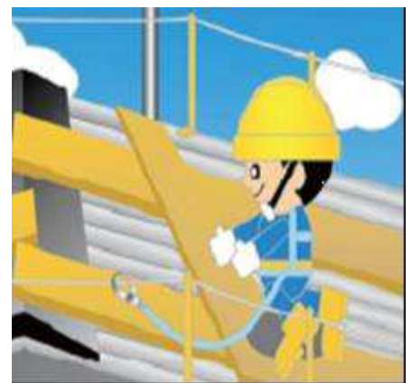
說明：屋頂作業應於屋架上設置適當強度，且寬度在 30 公分以上之踏板或裝設安全護網。
