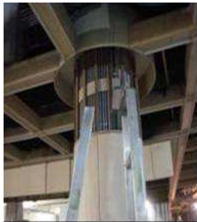
說明：自高度約 3 樓樓地板處墜落。
