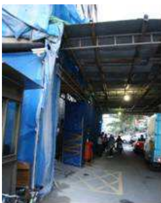
說明：鐵皮棚現場照片。
