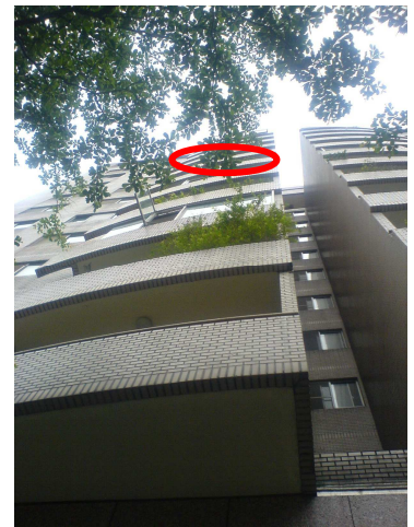
說明：裝修工地外觀（紅圈處為7樓窗戶位置）。
