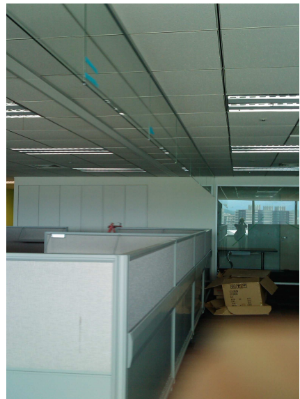
說明：裝修工地現場，防煙垂 壁玻璃安裝位置。
