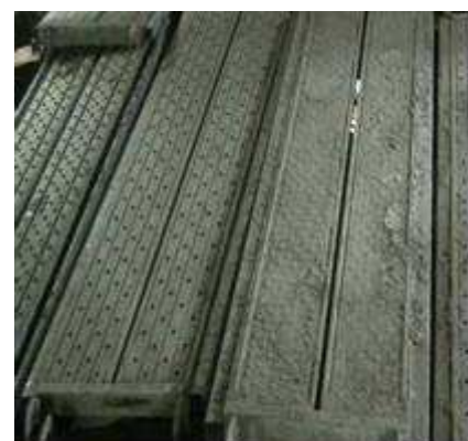
說明：作業區域施工踏板滿鋪。
