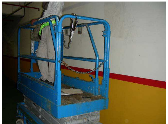
說明：使用高空工作車取代高度 2 公尺以上合梯清潔作業
