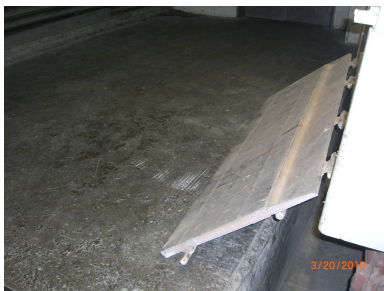
說明：貨車停靠在卸貨平台卸貨。
