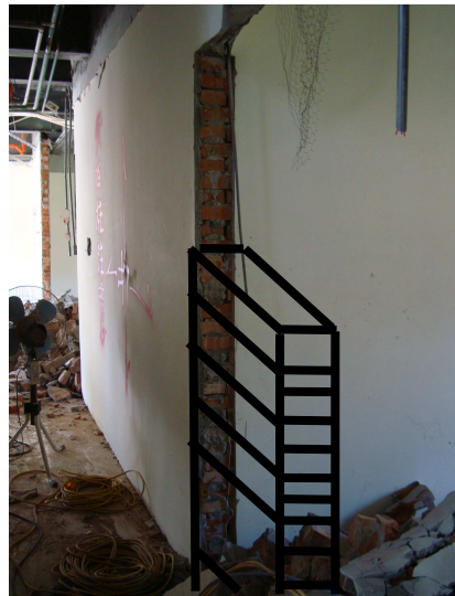
說明：倒塌牆之尺寸：高 140 cm * 寬 11 cm * 長 23 cm。
