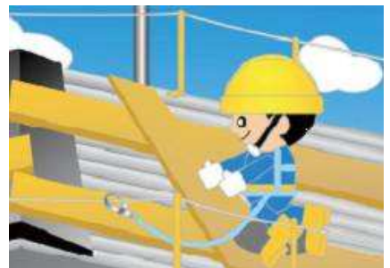
說明：屋頂作業應於屋架上設置適當強度，且寬度在 30 公分以上之踏板或裝設安全護網。
