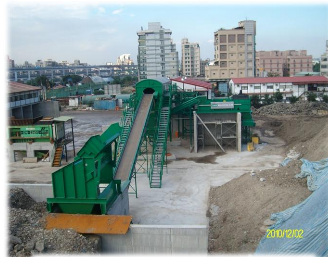
內湖垃圾山清除工程現場
