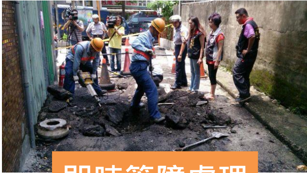
即時管障處理 管線破裂處置
