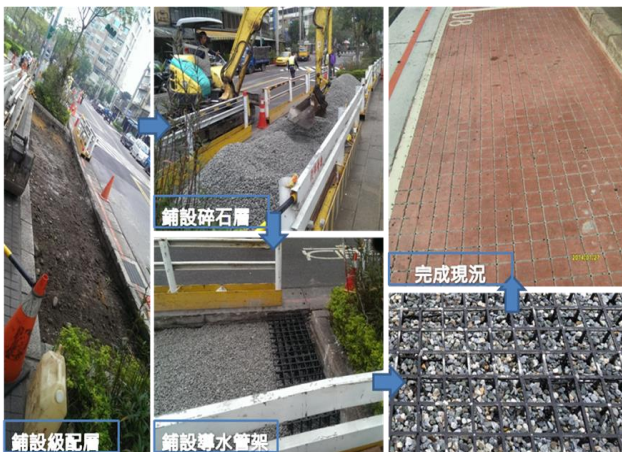
圖 3-11 至誠路及雨聲街試辦工程施工照
