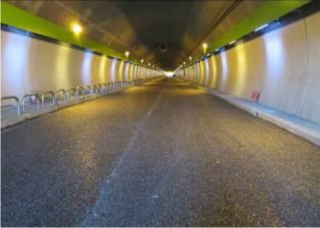
圖 3-1 辛亥隧道試辦工程施工照
