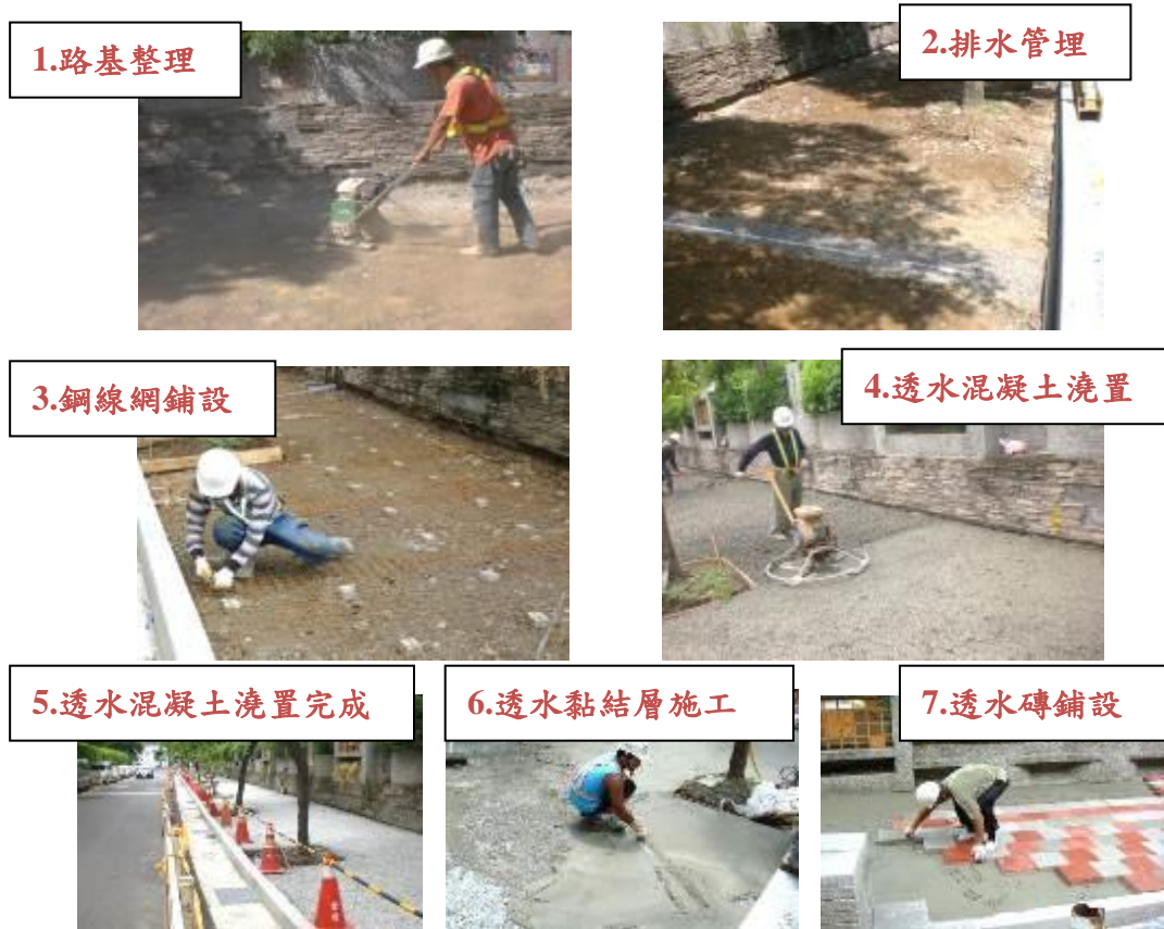
圖 3-13 士林區文昌國小周邊人行道更新工程施工照
