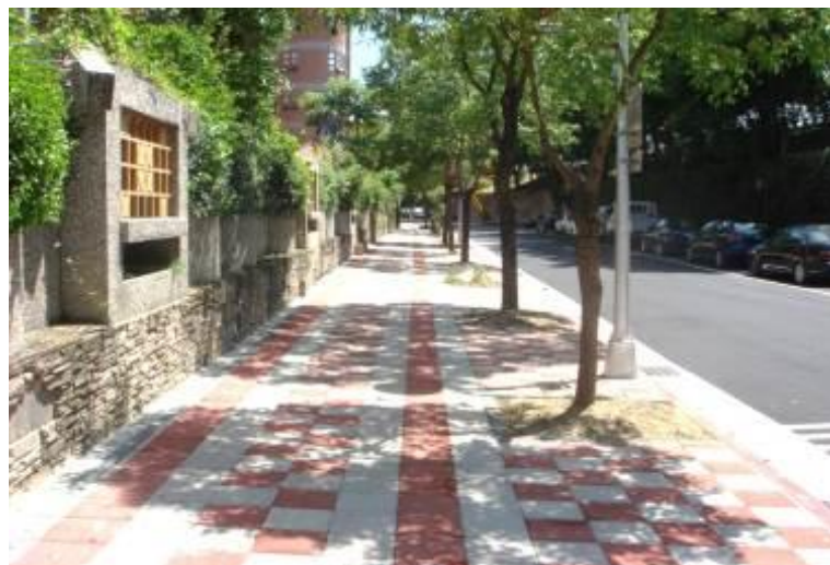
圖 3-14 士林區文昌國小周邊人行道更新工程完工照
