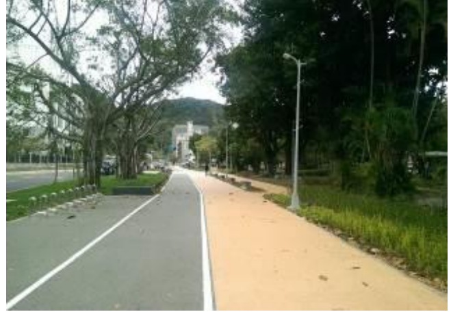
圖 3-16 北安路 501 巷工程完工照
