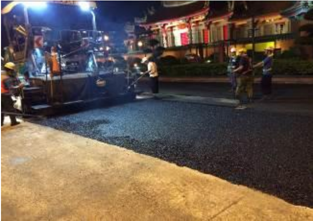
圖 3-5 民權東路 2 段試辦工程施工照
