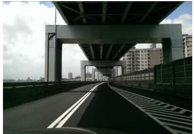
圖 3-8 水源快速道路試辦工程完工照
