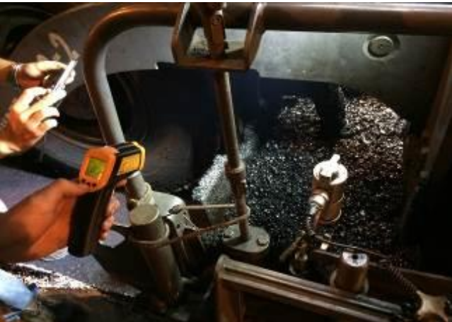
圖 3-3 成功路 2 段試辦工程施工照
