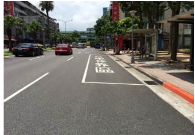
圖 3-4 成功路 2 段試辦工程完工照
