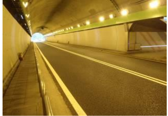
圖 3-2 辛亥隧道試辦工程完工照
