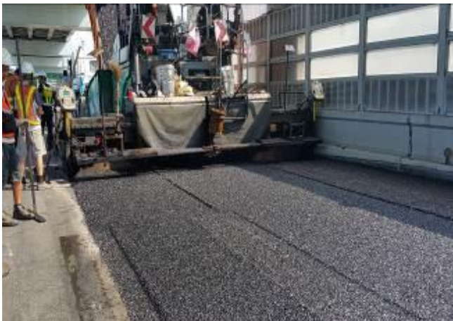
圖 3-7 水源快速道路試辦工程施工照
