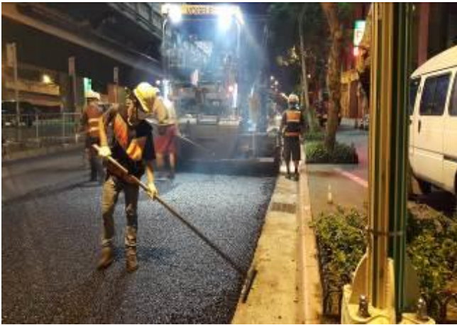
圖 3-9 建國北路 2 段試辦工程施工照
