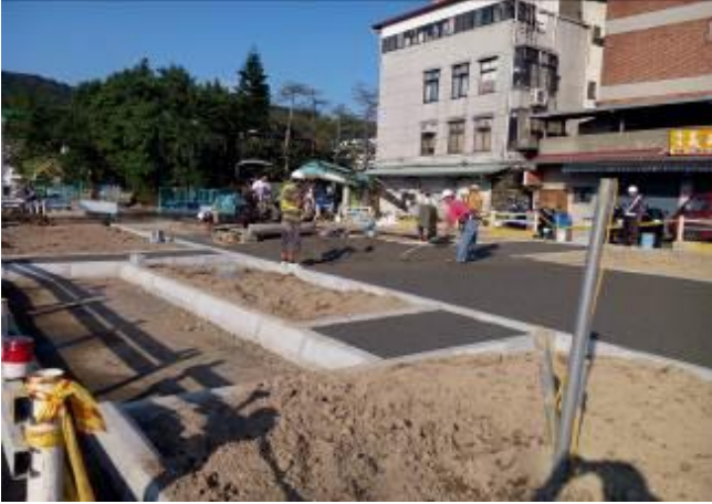
圖 3-15 北安路 501 巷工程施工照
