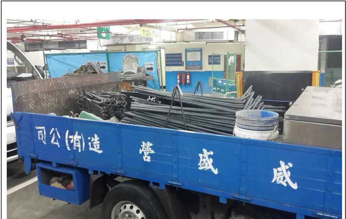
104年2月25日 13:26 中間樁帽頭所需植筋材料進場
