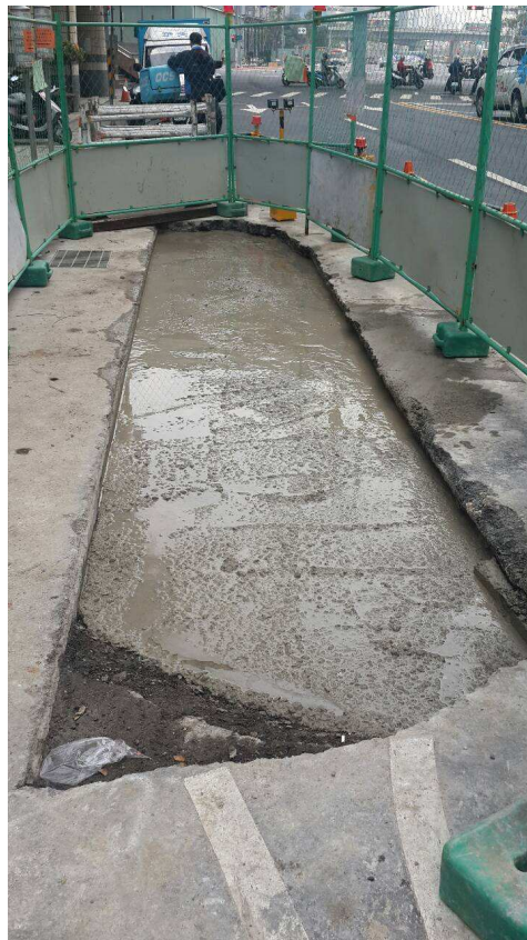
104年2月25日 15:20 路面 CLSM 已澆置完成
