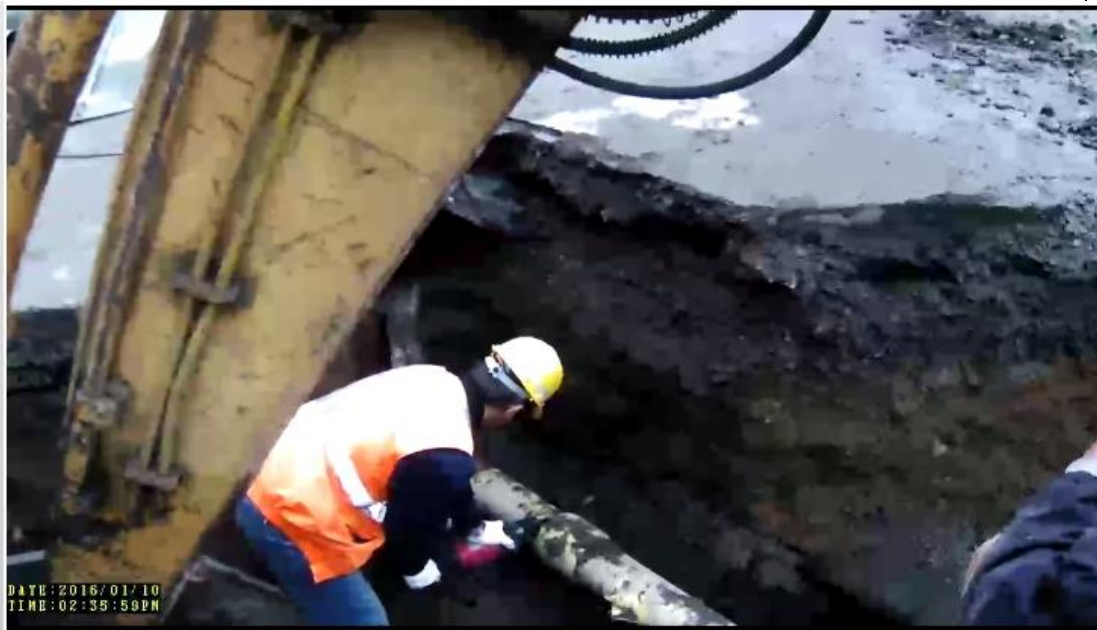
14:35 進行切割挖損管線作業
