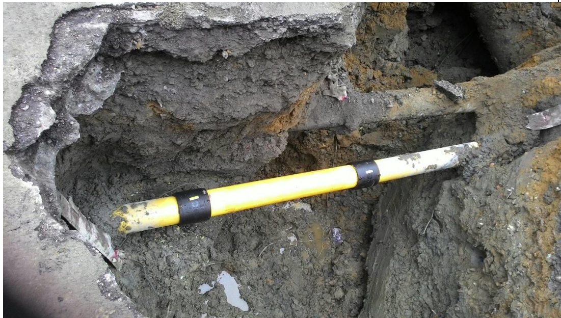
15:16 修復完妥，並確認現場無漏氣情形
