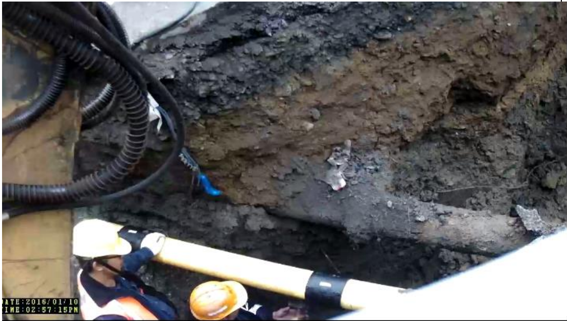
14:57 更換挖損管線
