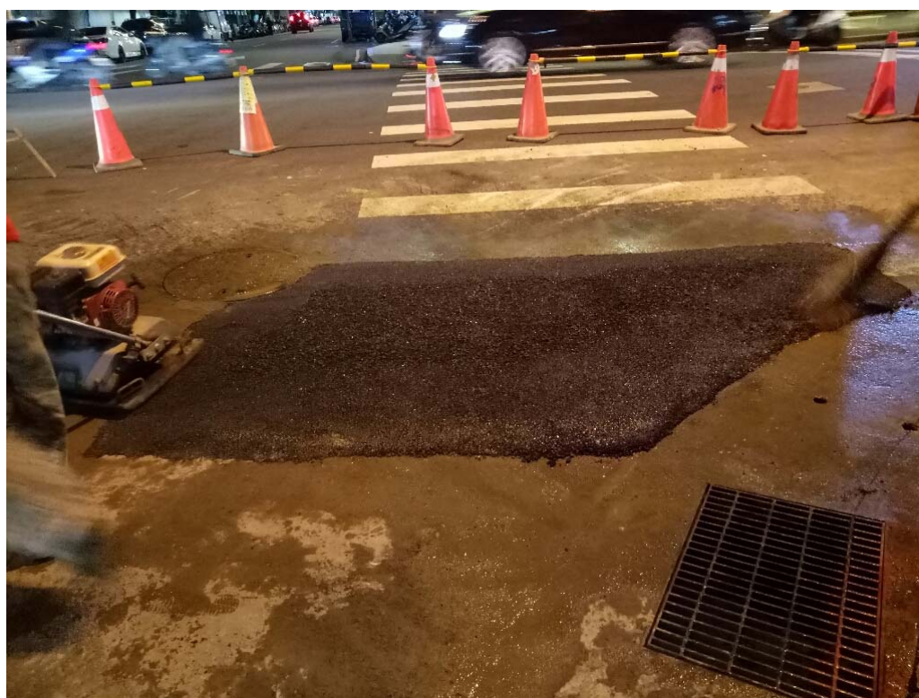
圖一康定路 94 號、內江街口現場修復完成情形
