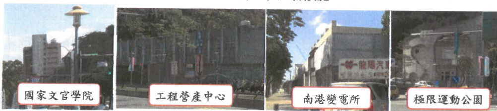
基地南側現有建物設施
