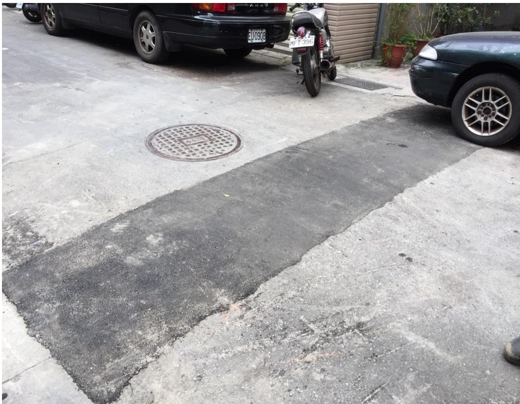
3/31 11:55 第 2 處疑似漏氣點開挖(明德路 174 巷 2 號旁)
