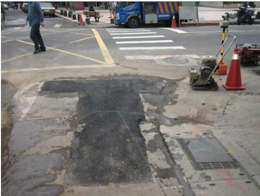
17:40 路面修復完成
