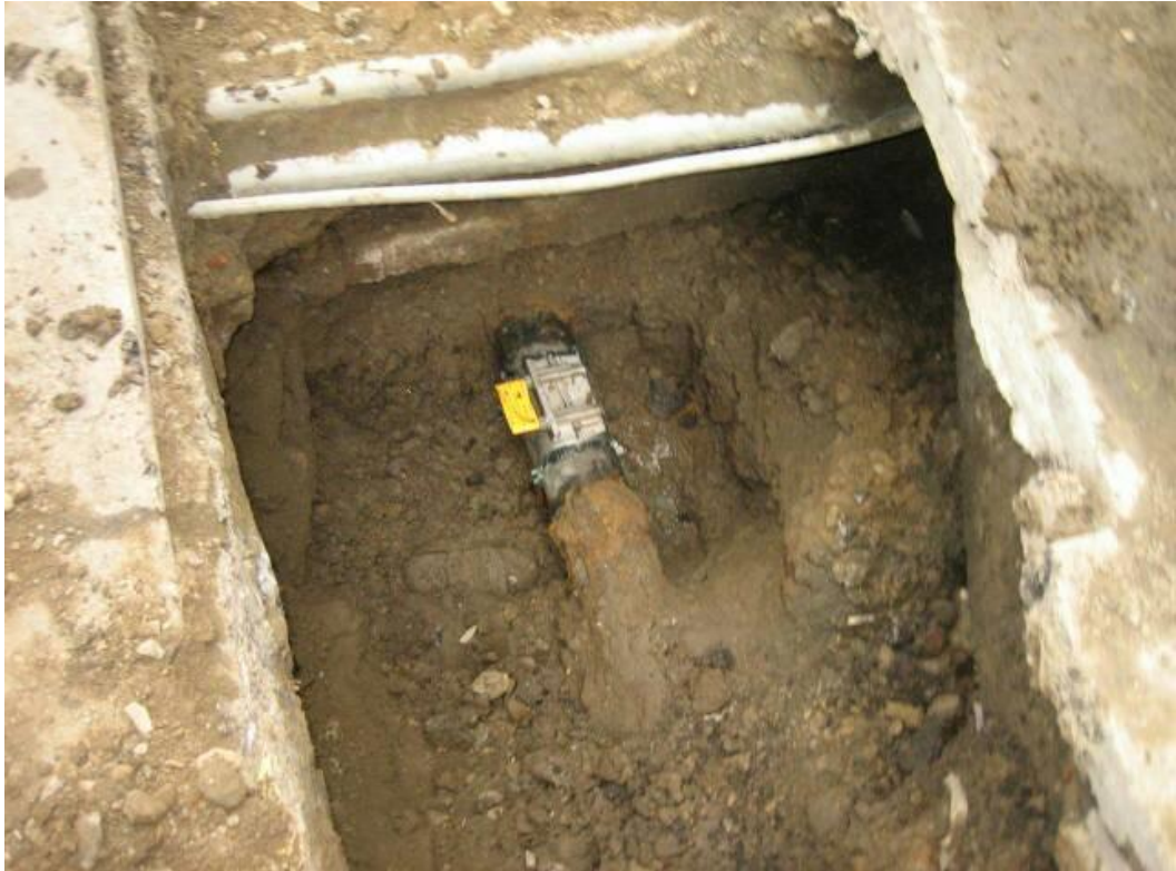
15:30 漏氣點處理完成
