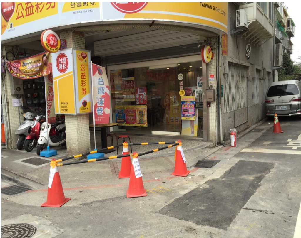
3/30 09:30 第 1 處疑似漏氣點開挖(明德路 174 巷口)
