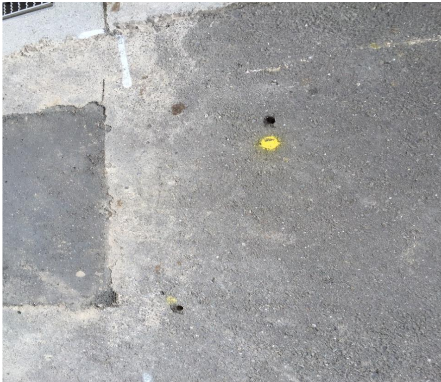
3/30 09:00 第 1 處疑似漏氣點測漏孔洞(明德路 174 巷口)
