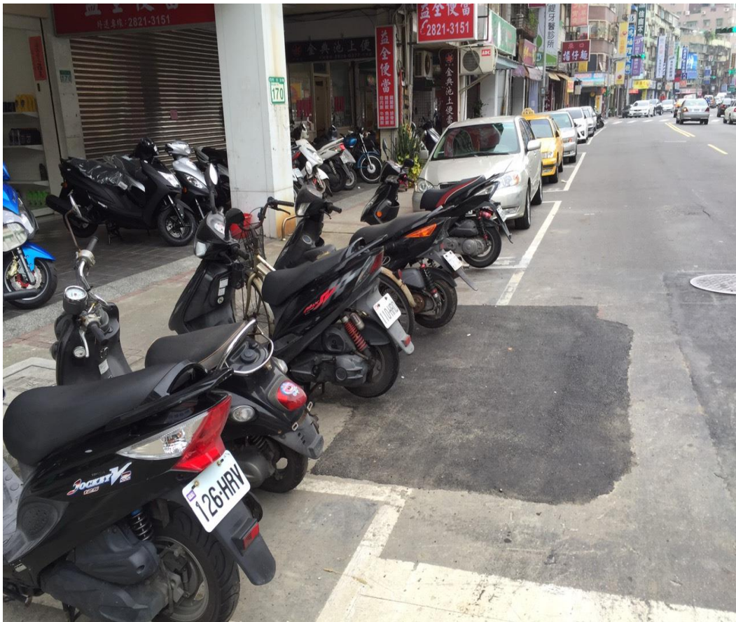
4/1 10:40 第3處疑似漏氣點開挖(明德路 170 號旁)
