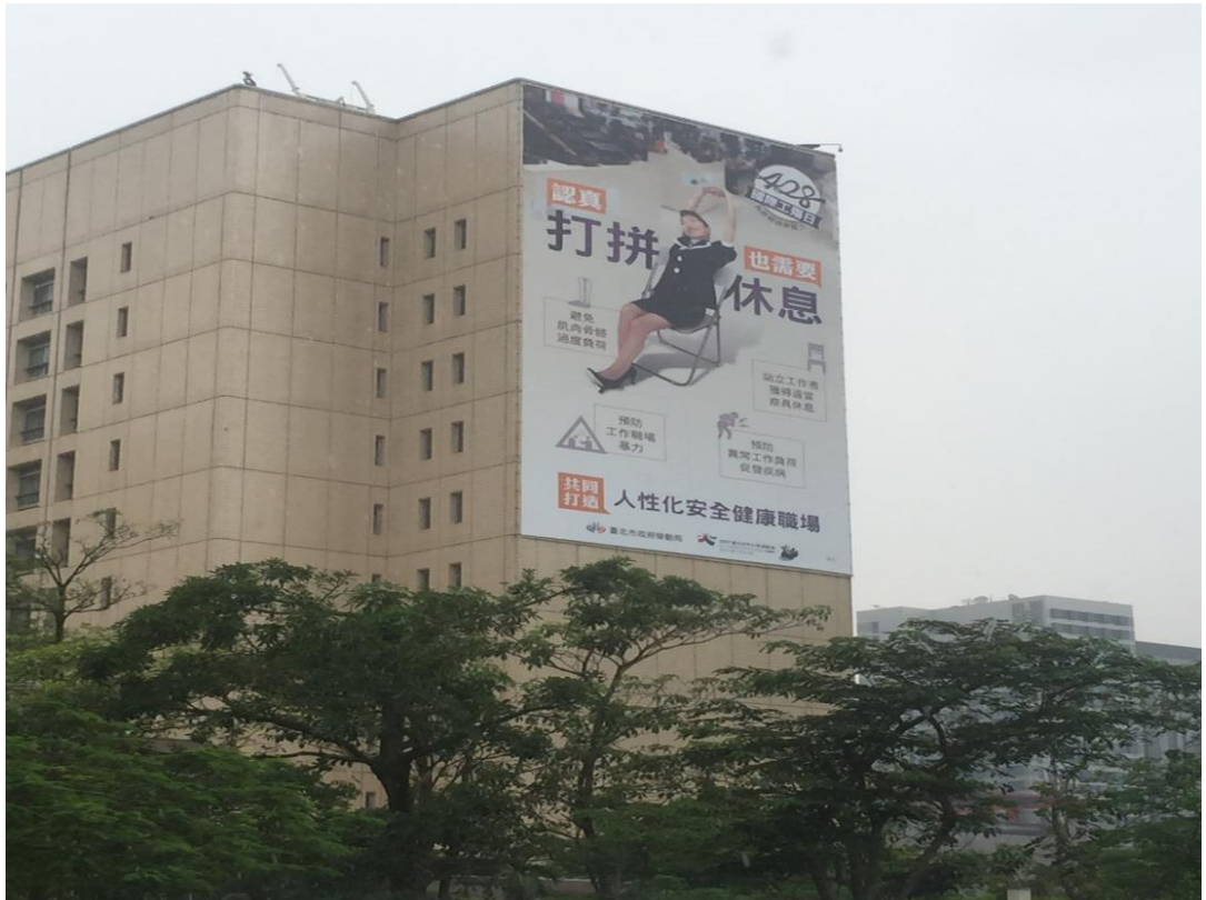
照片 7：市府南區外牆懸掛巨幅宣導海報
